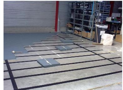
**5) Une dalle de mise à la terre doit être placée tous les 80-100m2 ou dans chaque pièce individuelle en suivant les étapes suivantes:**
